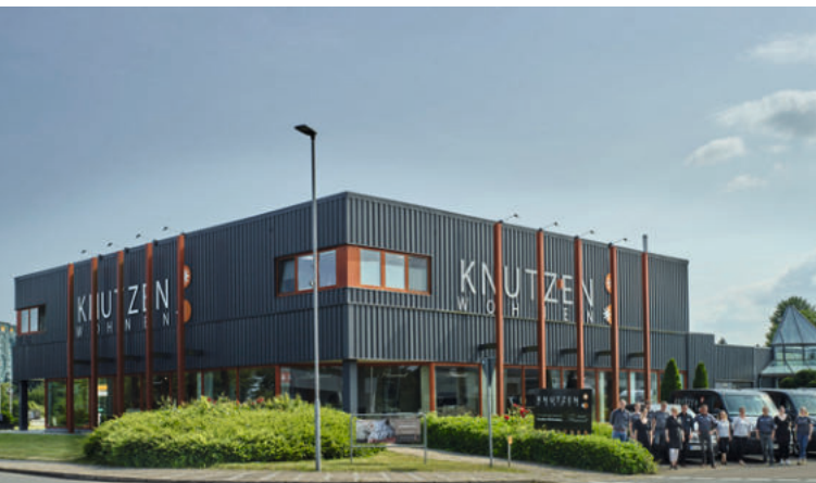
Fotos: © www.schmolzeundkuehn.de, Mitte: Trendwerk Fotografie
